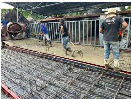
รูปที่ 2-14 รายละเอียดการเสริมเหล็กของพื้นสะพานจำลองความหนา 0.20 เมตร
