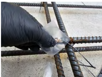
รูปที่ 3-5 การติดตั้งอุปกรณ์วัดความเครียดในเหล็กเสริม
