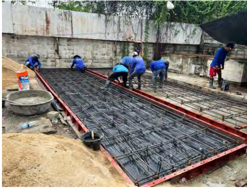
รูปที่ 2-20 รายละเอียดการเสริมเหล็กของพื้นสะพานจำลองความหนา 0.15 เมตร
