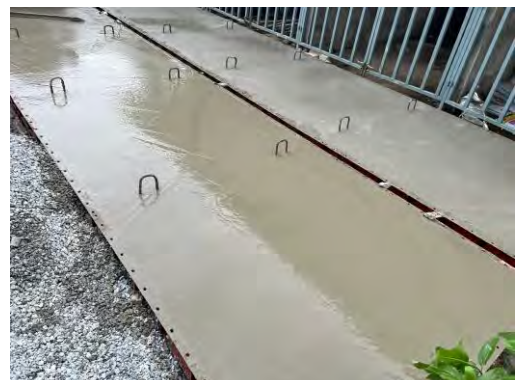
รูปที่ 2-14 รายละเอียดการเสริมเหล็กของพื้นสะพานจำลองความหนา 0.20 เมตร
