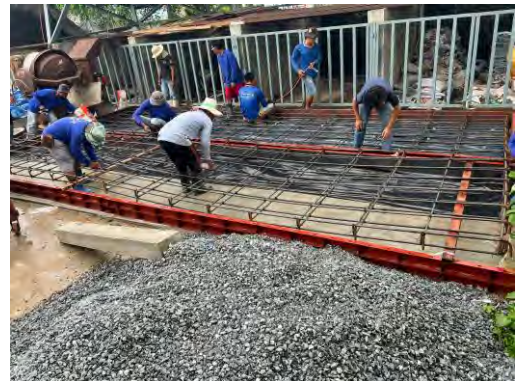
รูปที่ 2-13 รายละเอียดการเสริมเหล็กของพื้นสะพานจำลองความหนา 0.20 เมตร
