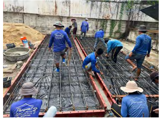
รูปที่ 2-20 รายละเอียดการเสริมเหล็กของพื้นสะพานจำลองความหนา 0.15 เมตร
