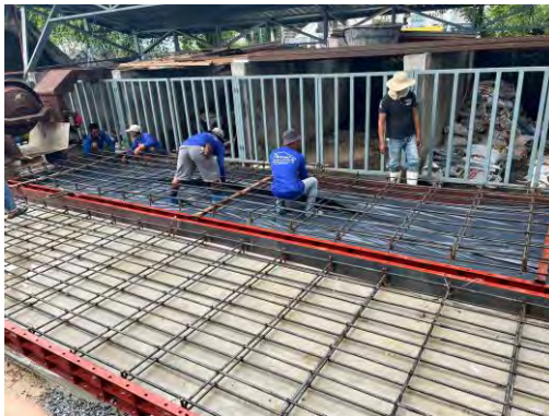
รูปที่ 2-13 รายละเอียดการเสริมเหล็กของพื้นสะพานจำลองความหนา 0.20 เมตร
