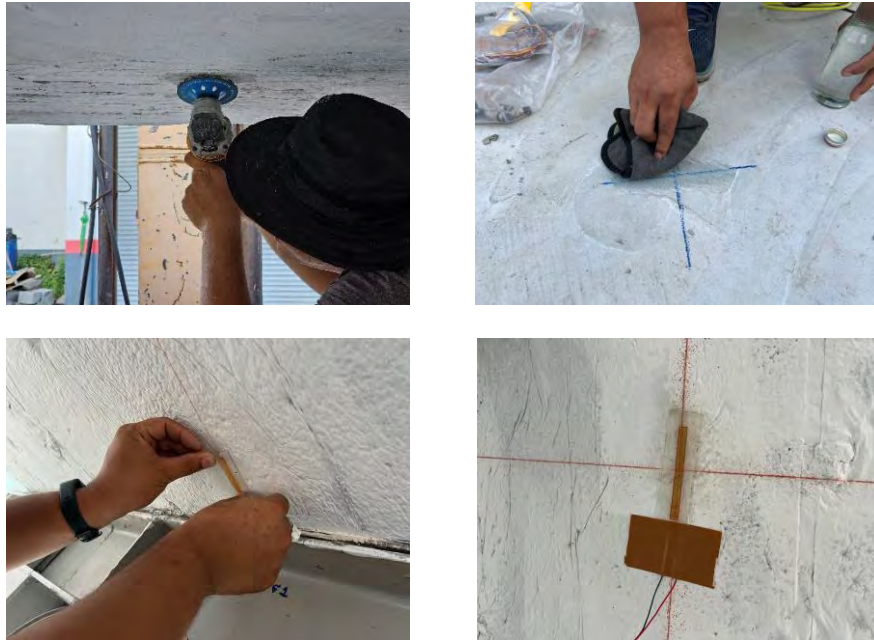
รูปที่ 3-6 การติดตั้งอุปกรณ์วัดความเครียดบนผิวคอนกรีต
